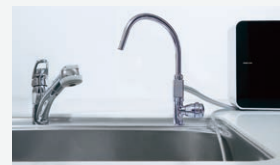
After(立上工事例)
